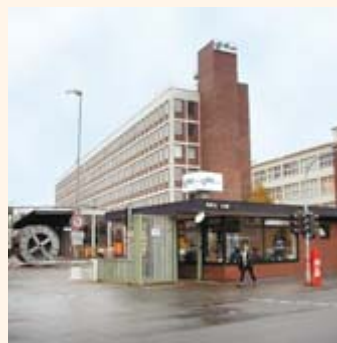
NKT-Cables in Köln
