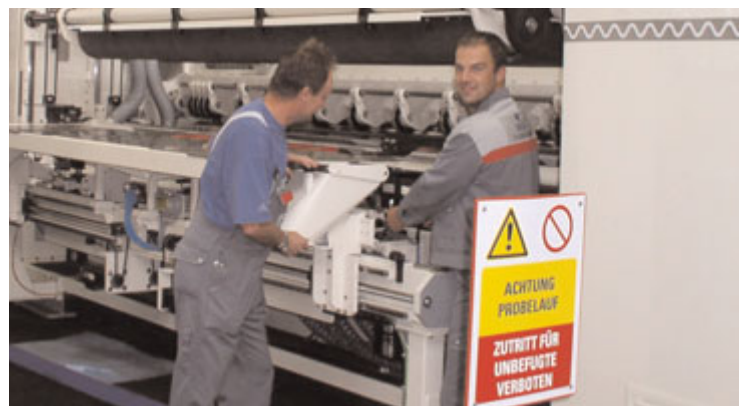
Installation der Komponente Schneid- und Rillautomat einer Wellpappanlage
