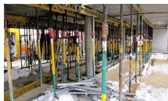
Säulenwald im künftigen Parkdeck
